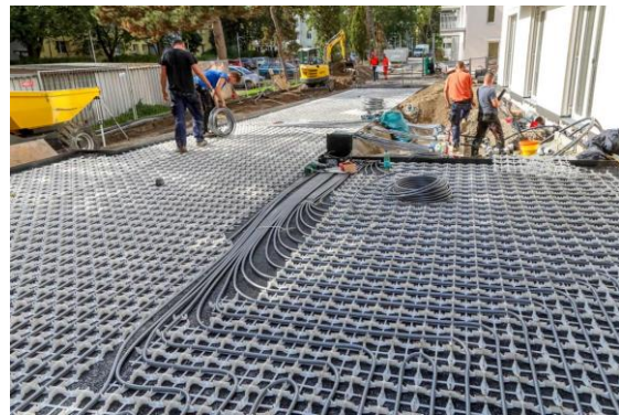
Gehsteig Asphalt-Kollektor
